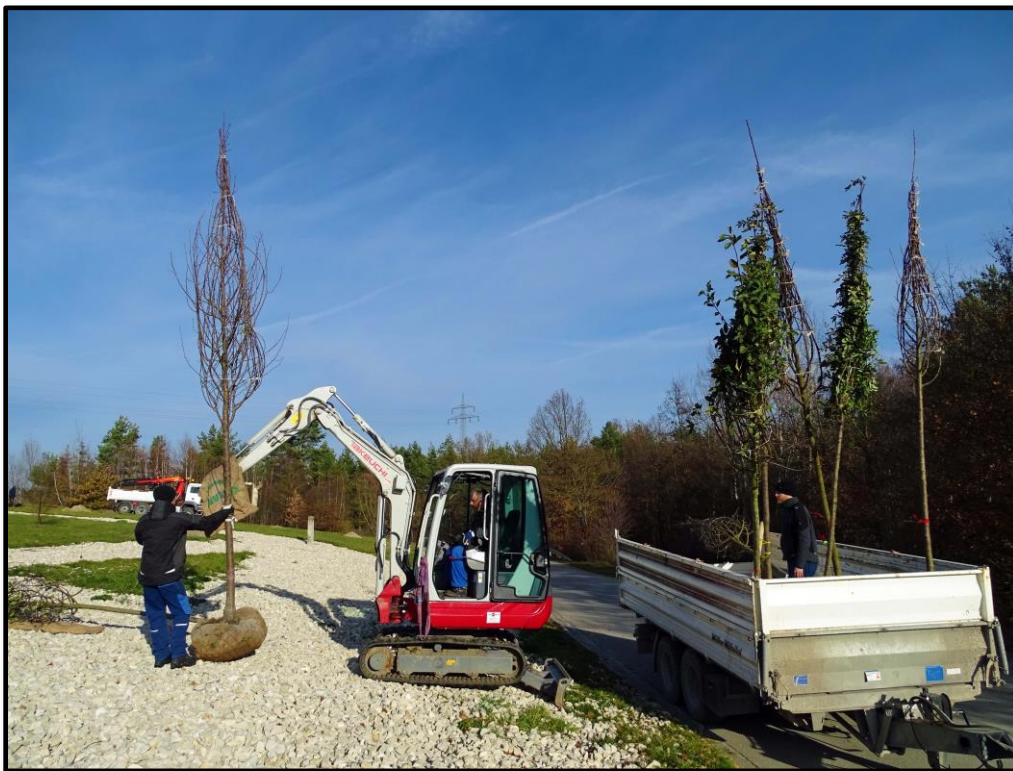
◀ Abb. 8 Pflanzarbeiten an der Schleuse Eibach
