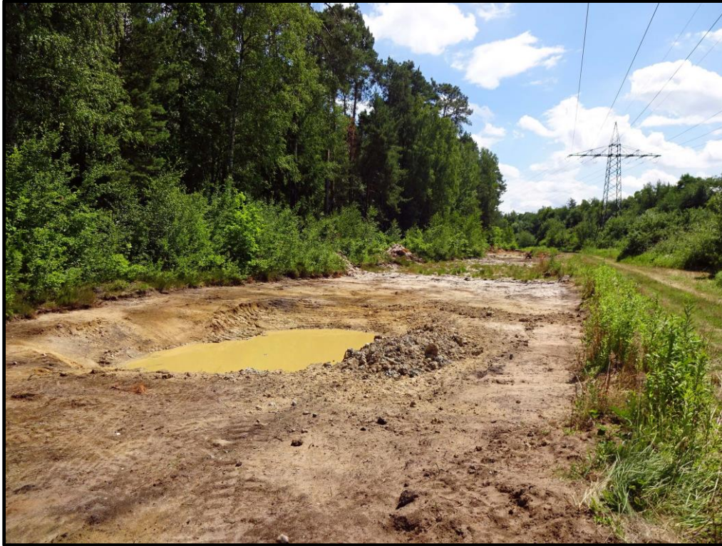
◀ Abb. 15 Artenschutz- maßnahme am Sand- Band: Frisch gebaggerte Stillgewässer für die Kreuz- kröte
