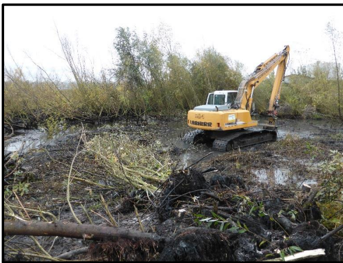
Räumung des RRB 2 am Bucher Landgraben
