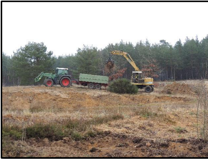
Baggerarbeiten im NSG
