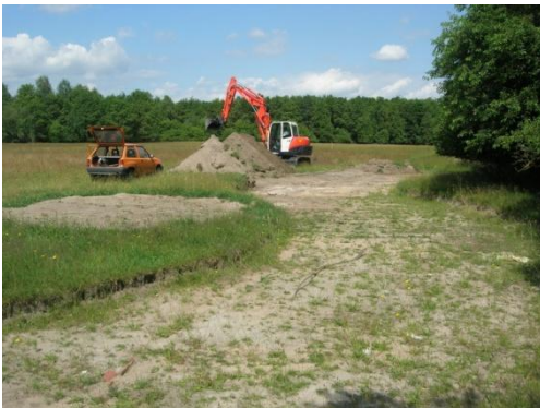
Vor der Verlegung des Brandgrabens
