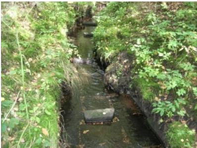
Verbaute Sohle des Katzenbachs
