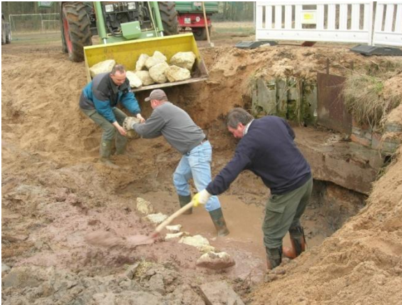
Neuerrichtung eines Wehrs
