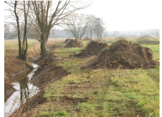
Nach den Maßnahmen
