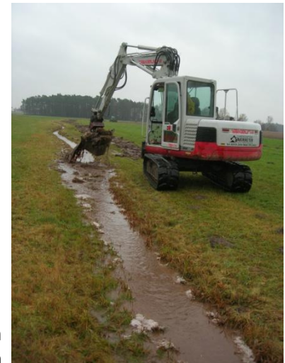
Maßnahmen am Gaulnhofener Graben
